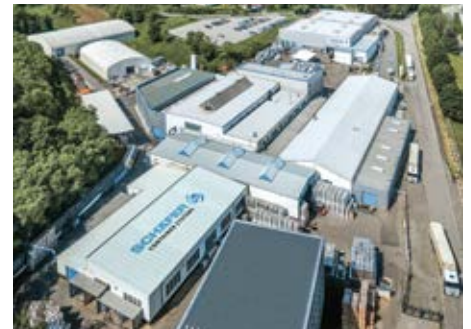
Plant at Leděč nad Sázavou (CZ)
