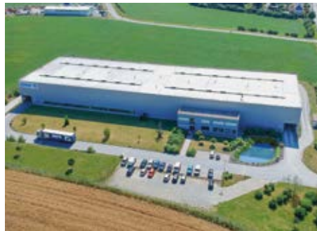
Plant at Treuen (D)
