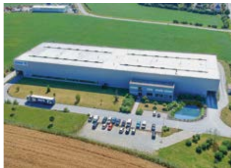
Plant at Treuen (D)
