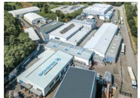
Plant at Leděč nad Sázavou (CZ)
