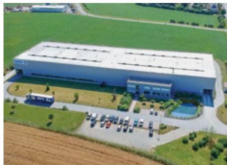
Plant at Treuen (D)
