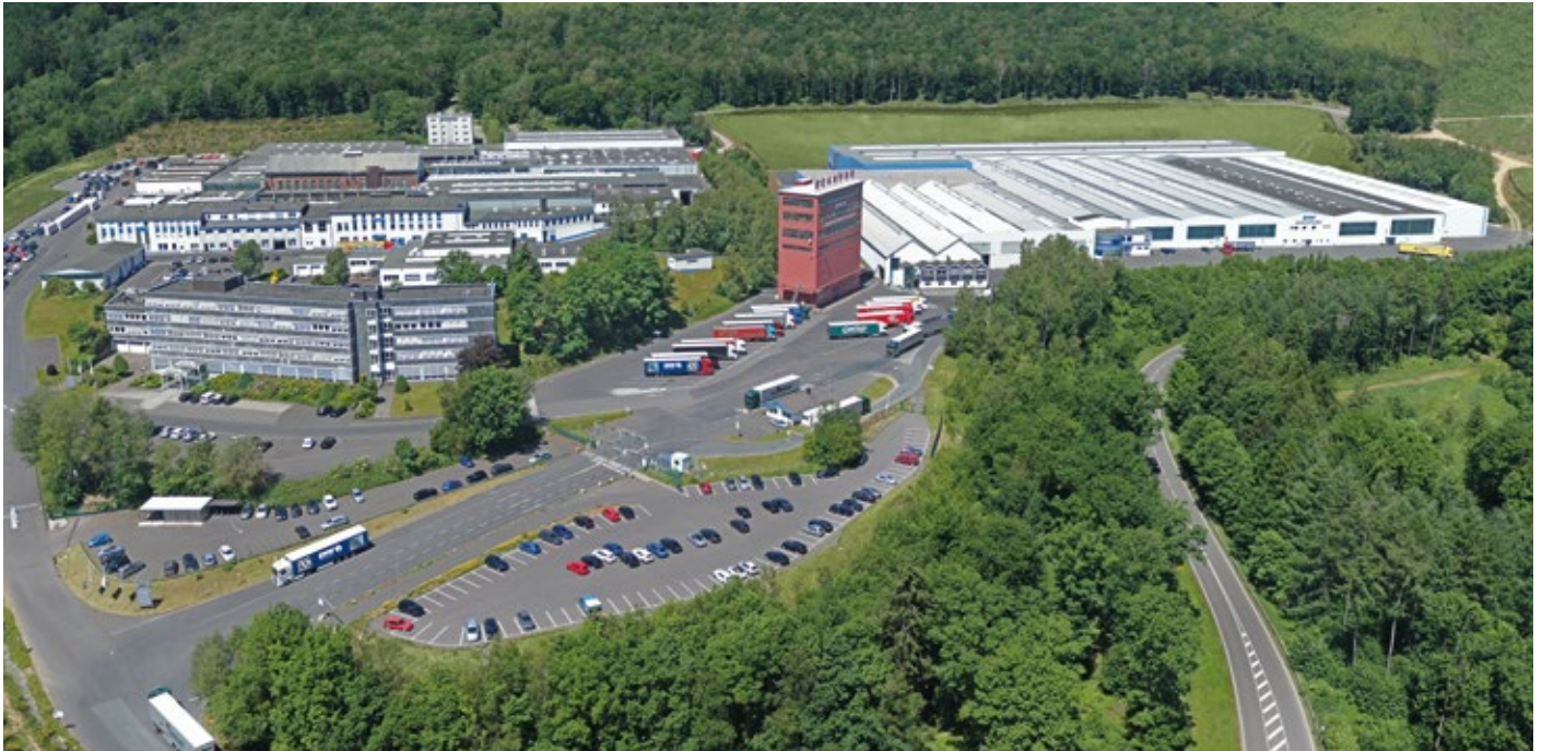
Head office and production site at Neunkirchen (D)
