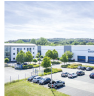
Werk OKS Iserlohn plant (D)
